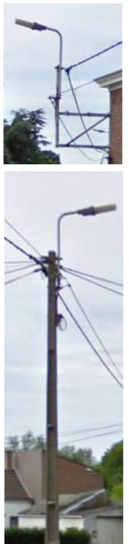
Exemple d'appareils de type «fonctionnel haut sur mât» et « en console»
