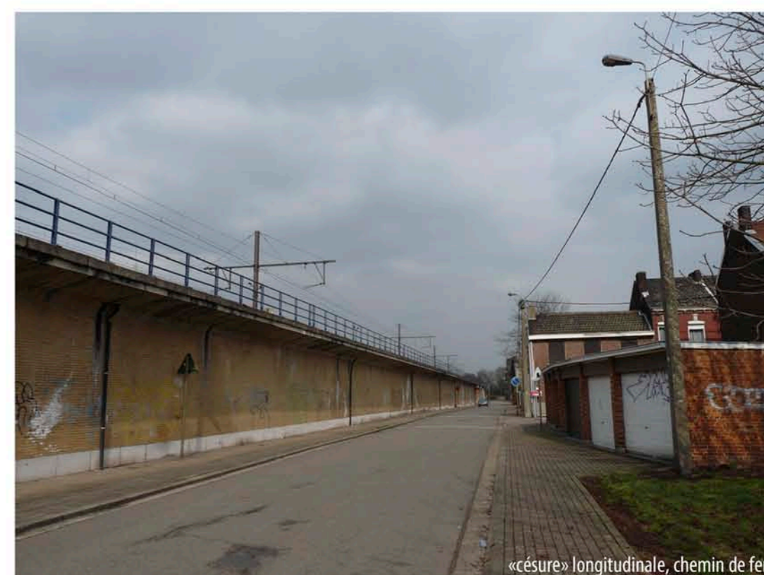
trottoir le long des voies de chemin de fer
